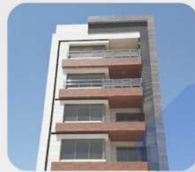
پروژه ۱۰ طبقه تجاری مسکونی (مهندس تارنگ و مهندس توحیدی)
