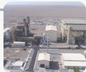
پروژه نیروگاه سیکل ترکیبی سمنگان سیرجان
