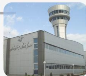
پروژه فرودگاه کرمان
